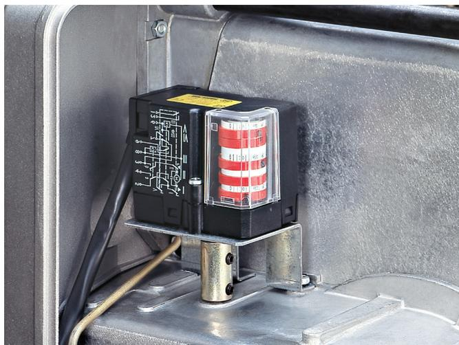
Esempio regolazione servomotore aria
