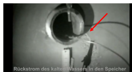
Cascata di acqua fredda all'interno del serbatoio
